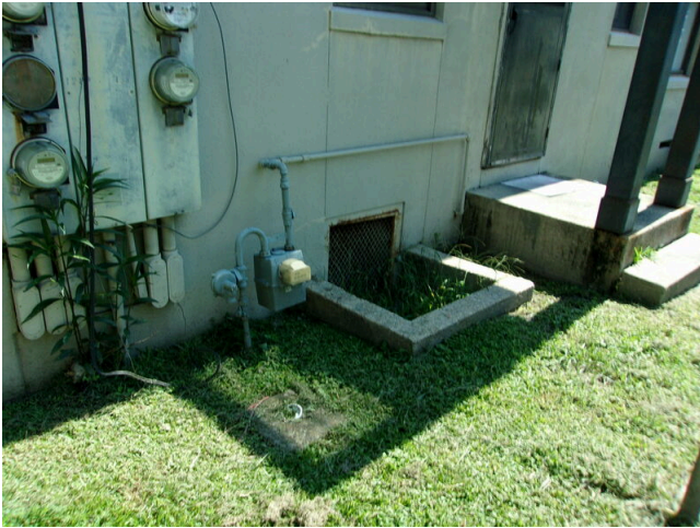
21. Crawlspace access door
